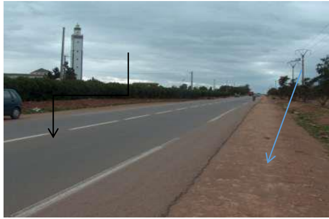
Figure 1 chaussée et accotement [5].
